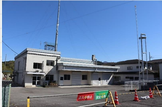
道路側から旧庁舎を撮影
