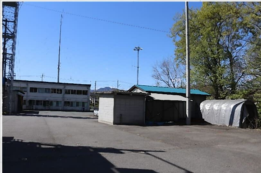
裏庭側から旧庁舎を撮影
