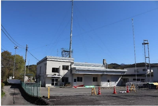
道路側から旧庁舎を撮影
