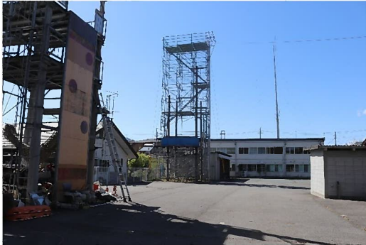
裏庭側から旧庁舎を撮影
