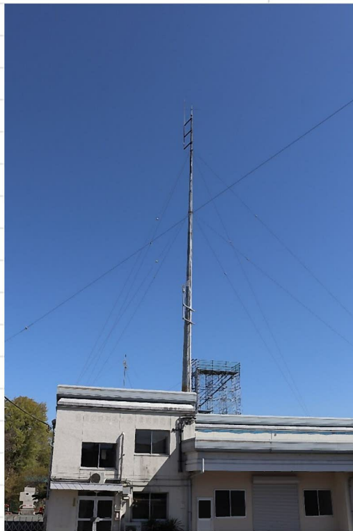
①旧庁舎屋上の電波塔を撮影
