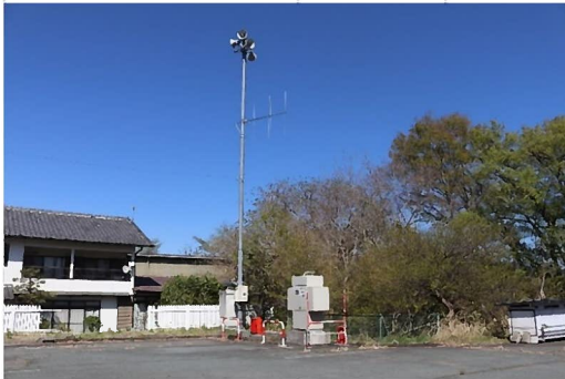
②発電機周辺を撮影
