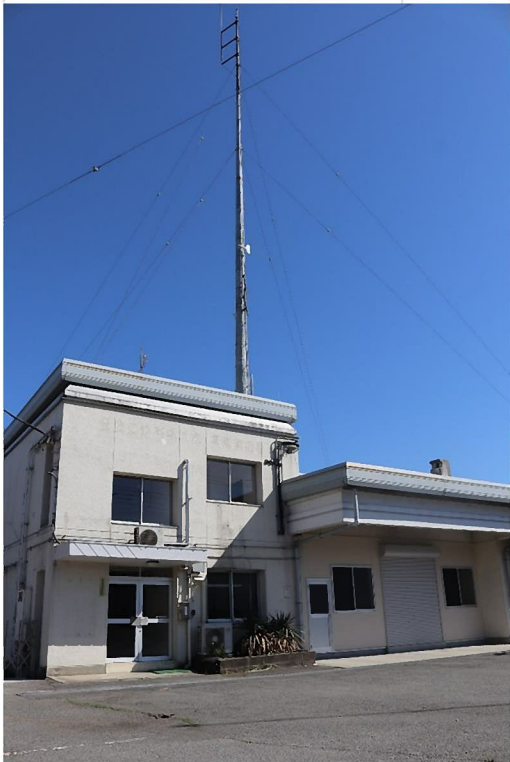
①旧庁舎屋上の電波塔を撮影
