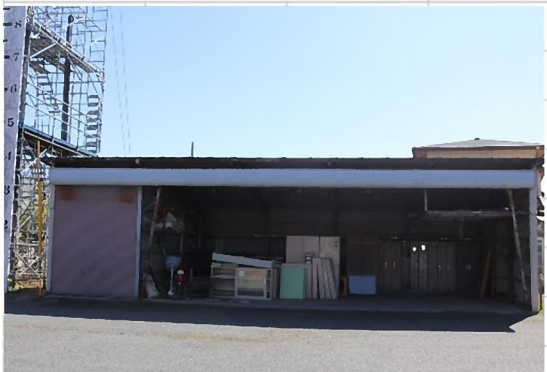
⑧倉庫内の残置物を撮影
