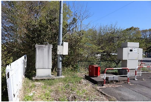
②発電機周辺を撮影
